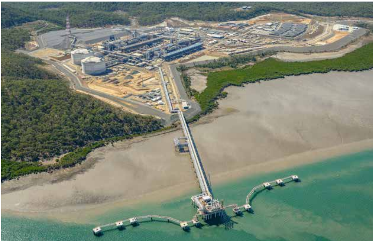
Figure 15. Gladstone LNG Plant
